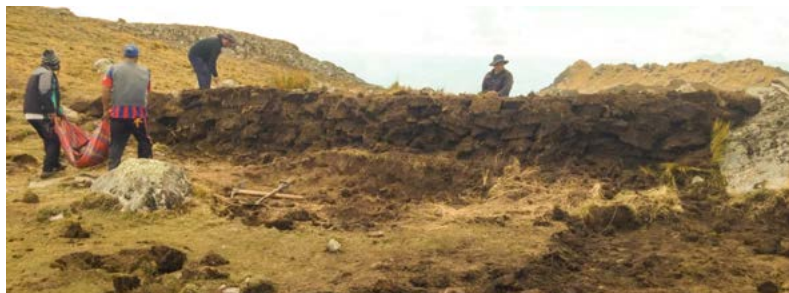
Trabajo en la construcción del dique de Mariaq'ocha Baja (Micaela Bastidas). Foto: CEDES Apurímac.
