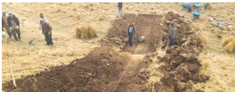
Construcción del dique de la cocha Yerbabuenayoc medio. Foto: CEDES Apurímac.
