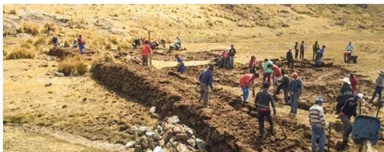
Trabajo en la construcción del dique de la cocha Occoruro (Micaela Bastidas). Foto: CEDES Apurímac.
