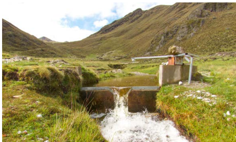
Vertedero con sensor ultrasónico en el caudal de la microcuenca testigo del SMEH en Rontoccocha. Foto: Jan R. Baiker.
