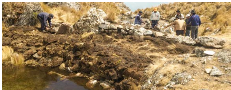
Trabajo en la construcción del dique de la Llauriccocha (Micaela Bastidas). Foto: CEDES Apurímac.
